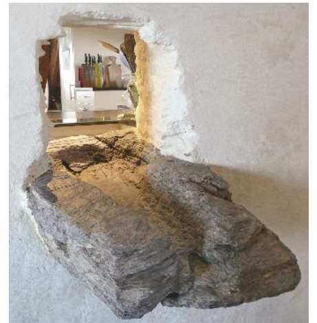
Der alte Schüttstein in der Küchenwand mit natürlicher Entwässerung gegen aussen.
