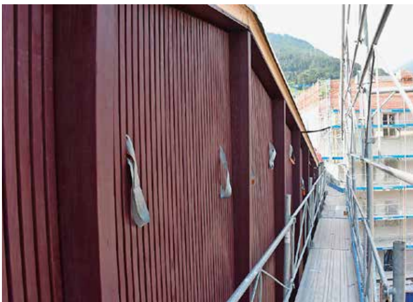
Im Zweischichtbetrieb: 50 bis 60 Kubikmeter einheimisches Holz bilden die Aussenfassade des Kulturzentrums. Noch im August sollen die Platten alle montiert werden.
