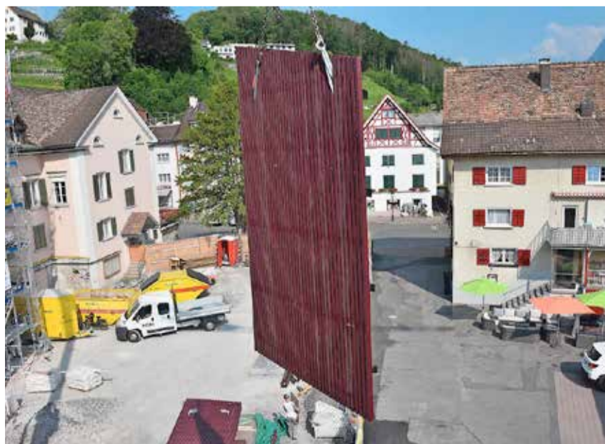
Im Zweischichtbetrieb: 50 bis 60 Kubikmeter einheimisches Holz bilden die Aussenfassade des Kulturzentrums. Noch im August sollen die Platten alle montiert werden.
