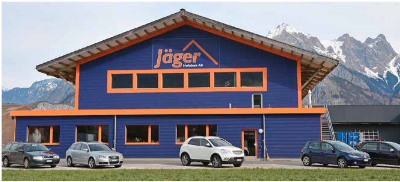
Der Bürotrakt als Pilotprojekt: Die der Werkhalle in Vilters vorgelagerten Büroräume sind in Vättis vorgefertigt und mit Holzfasern isoliert worden.
